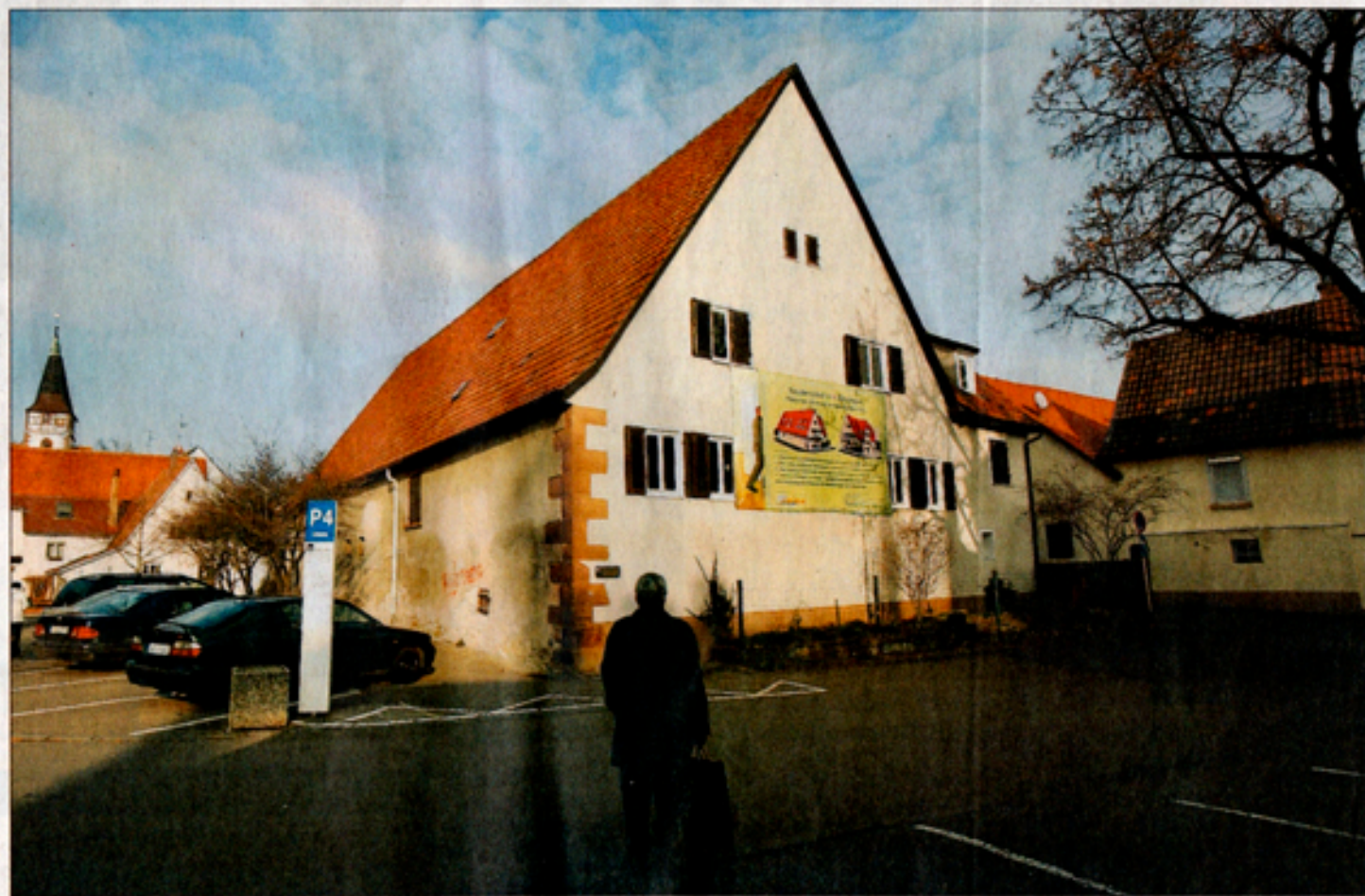
Der Hirsauer Pflegehof mit seiner Eckquaderung soll saniert werden. Hier entstehen fünf Eigentumswohnungen. Foto: factum/Rebstock
